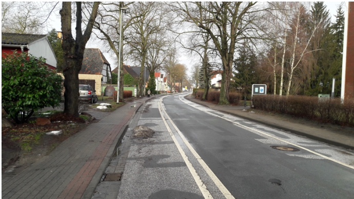
Foto EURAWASSER – 1. Bauabschnitt Bahnhofsviertel in Bützow
